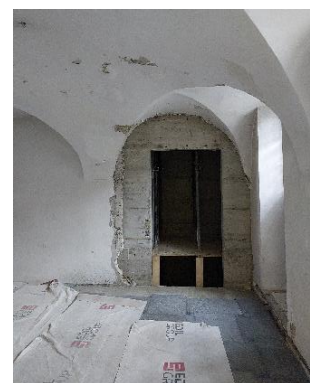
Inserimento vano lift al pt
