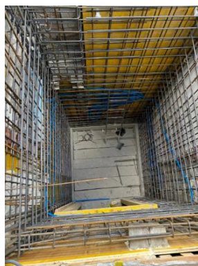
Armatura elevazioni vano lift
