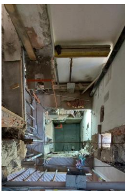
Vista al termine delle demolizioni
