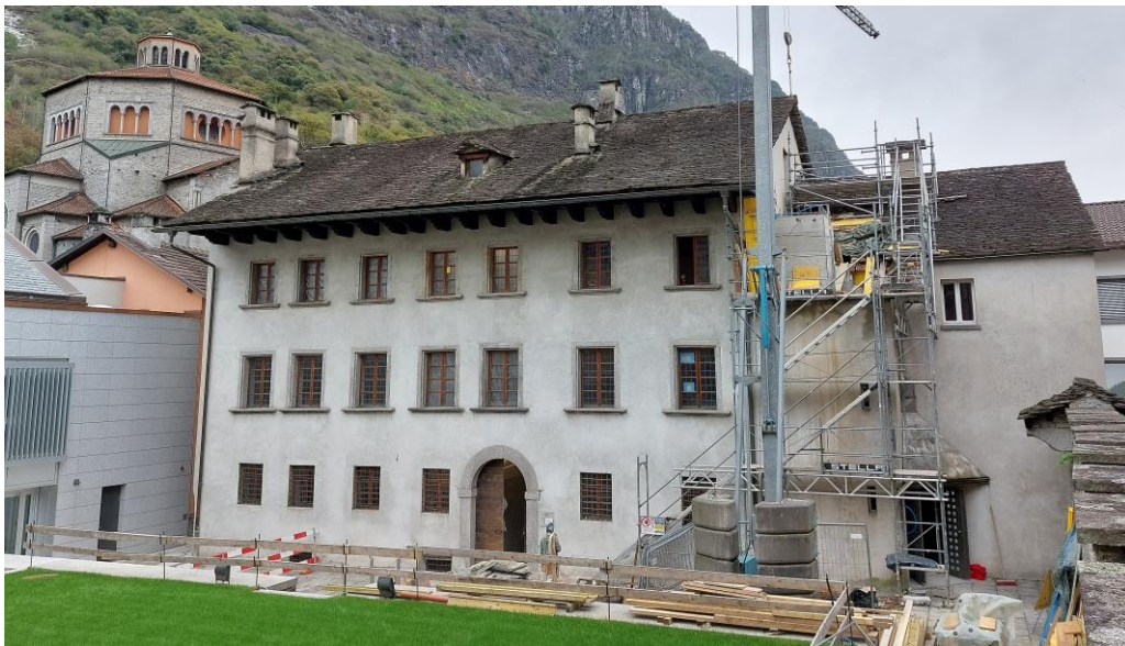
Vista cantiere prospetto Nord
