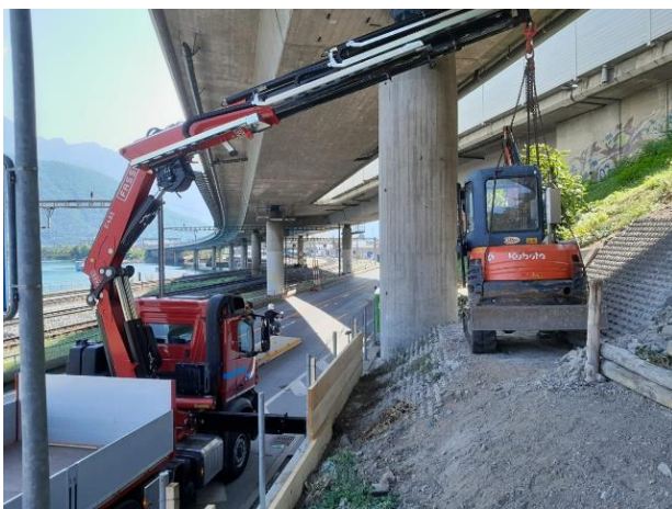
Preparazione dello scavo
