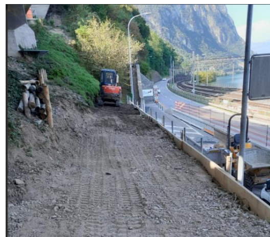
Preparazione dello scavo
