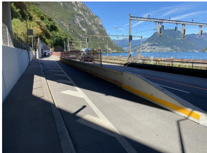
Vista d'insieme dell'area di cantiere
