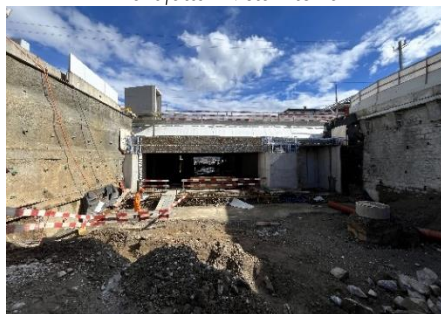
Manufatto – vista lato Besso
