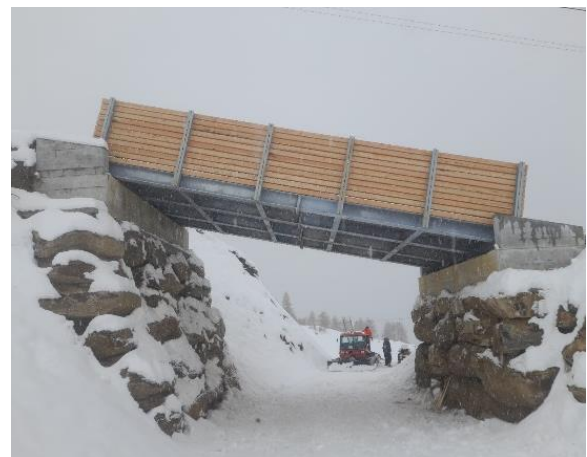
Ponte in carpenteria metallica e legno
