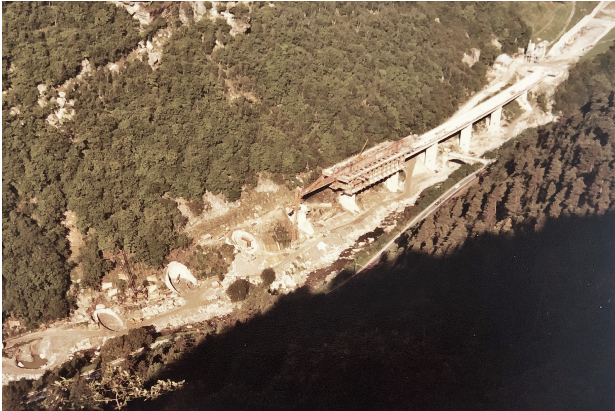
Viadotto della Ruina in costruzione, con la centina autovarante, 1982 (Archivio Filippini & Partner Ingegneria SA)
