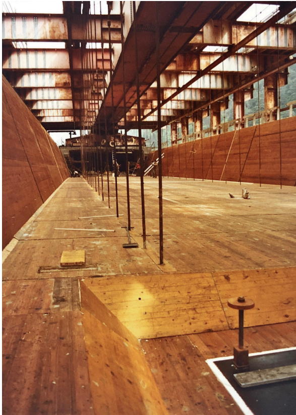
Vista dall'interno della centina autoarante per il getto dell'impalcato, 1982-1983 (Archivio Filippini & Partner Ingegneria SA)
