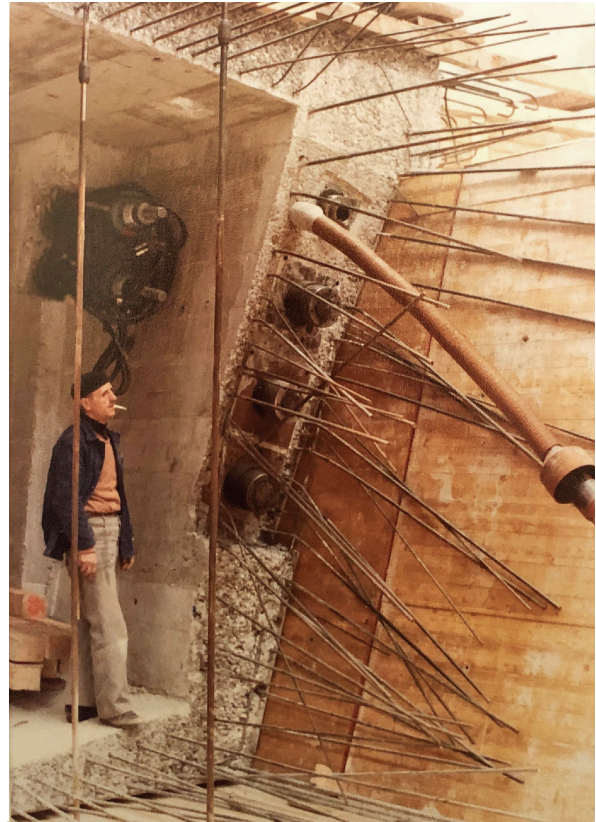
Dettaglio delle testate dei cavi di precompressione, 1982-1983 (Archivio Filippini & Partner Ingegneria SA)
