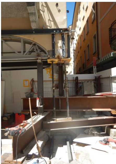
Sistema di sostegno provvisorio
