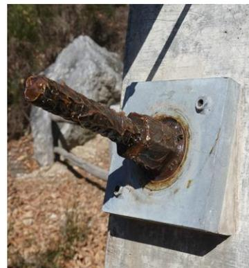
*Attività di ispezione con controllo e ingrassaggio delle teste di ancoraggio*
