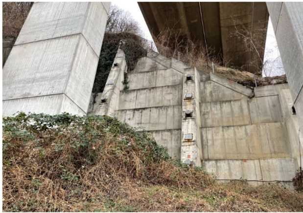
Viadotto Pianturino vista della parete di sostegno del versante e relativa modellazione FEM
