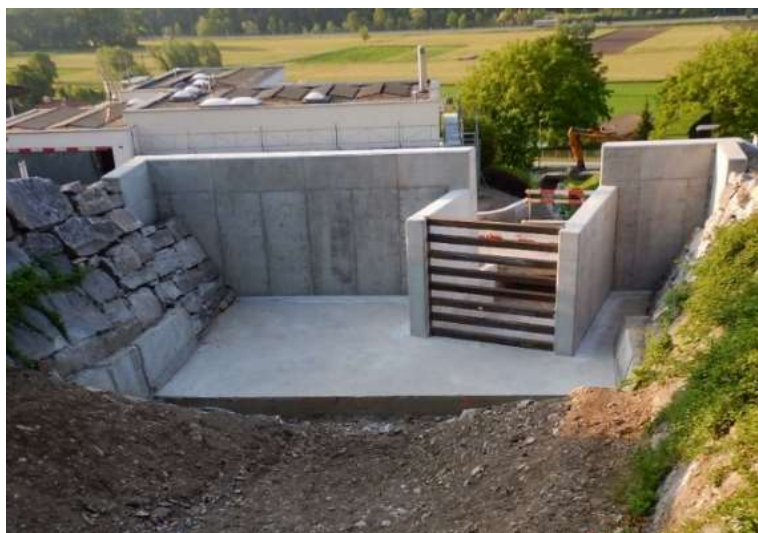
Nuova briglia – vista dall'interno della camera (maggio 2022)
