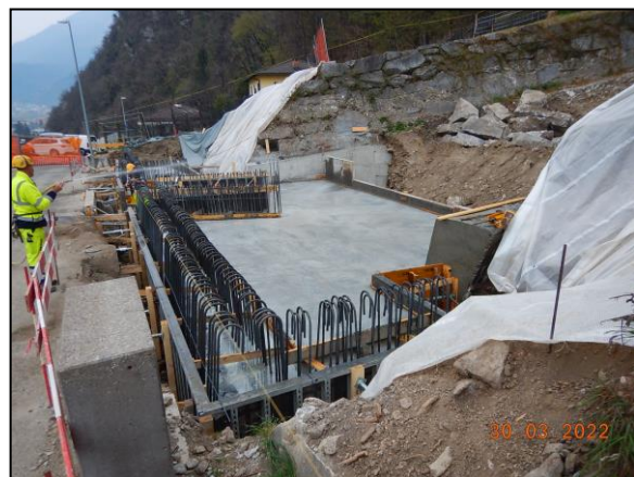
Stato lavori marzo 2022
