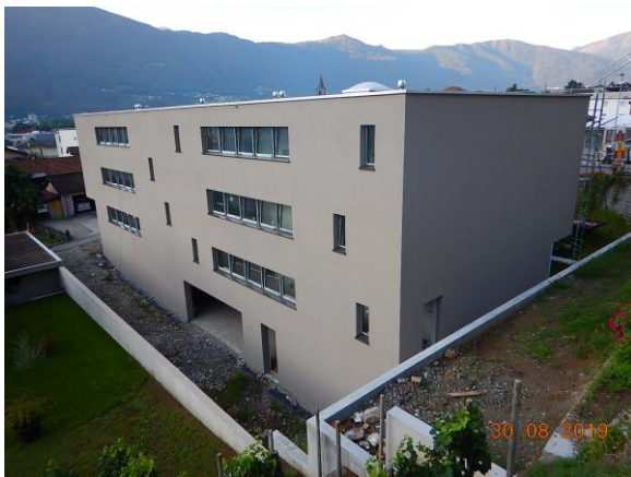
Vista da nord edificio in ultimazione
