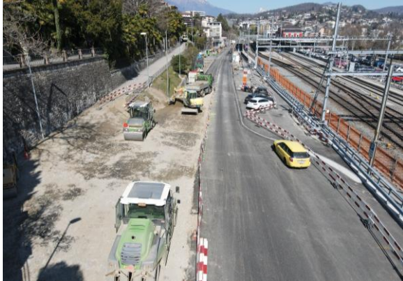
Vista rotonda in esecuzione
