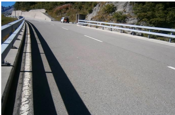
Tracciato e muri, vista panoramica
