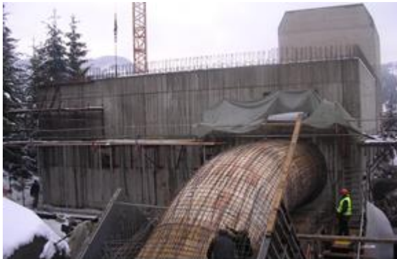
Ampliamento centrale di ventilazione Airolo
