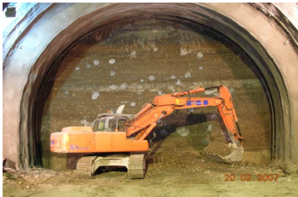
Lotto 8A: Sezione C2 - Fronte di scavo lato Milano
