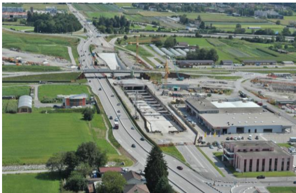
Sottopasso Strada Cantonale, Vista verso Est (ATG)
