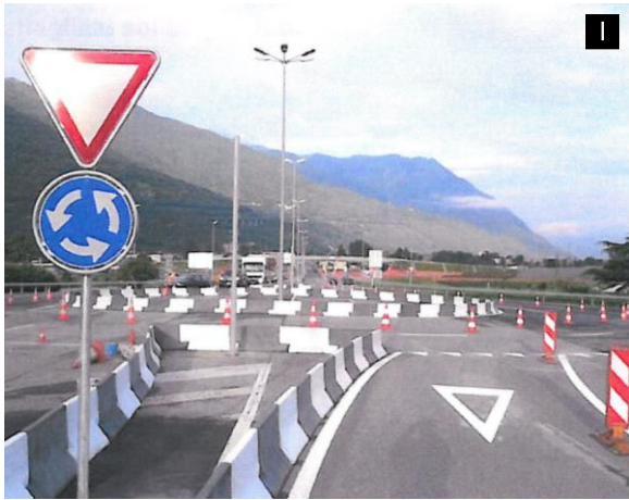
1 Rotonda Svincolo A2 Lotto 714 - AlpTransit Nodo di Camorino
