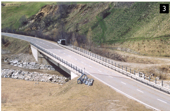
Ponte Villa Bedretto
