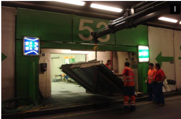
Galleria Stradale S. Gottardo - Porte rifugi
