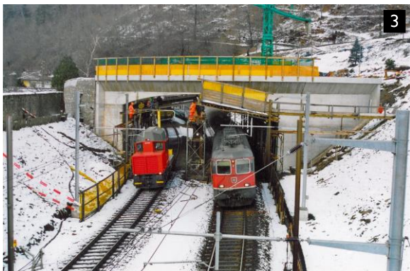
Sottopasso FFS - Faido Ospedale
