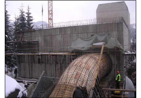
Ampliamento centrale di ventilazione Airolo (DLL) 2003-2004
