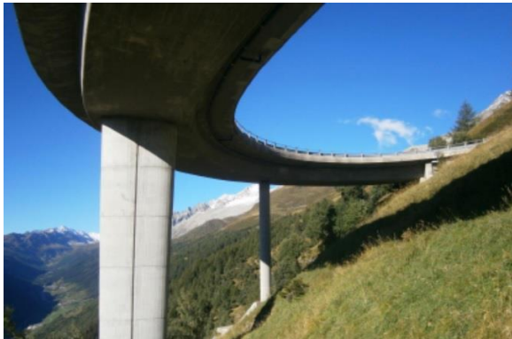
Viadotto Tomante di Fieud
