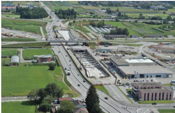
Sottopasso Strada Cantonale, Vista verso Est (ATG)
