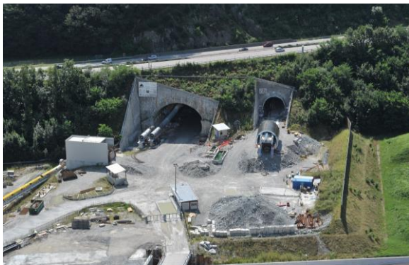
Attraversamento Autostrada A2 (ATG)
