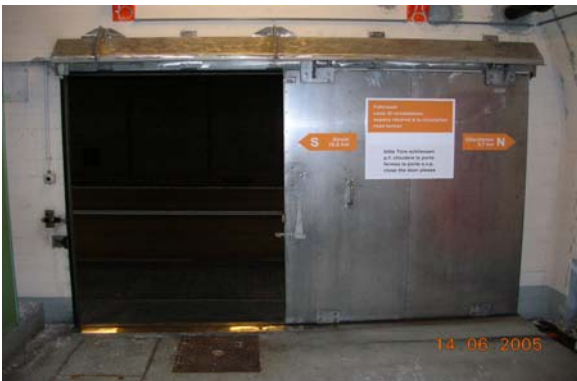
Porte rifugio lato Galleria
