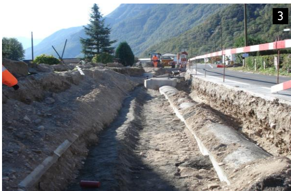
3 Tracciato e muri, vista panoramica Strada Cantonale Lodrino
