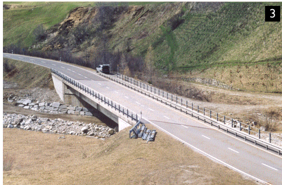
Ponte Villa Bedretto
