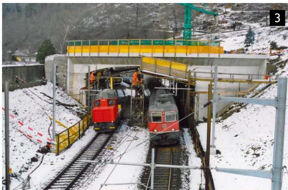
Sottopasso FFS - Faido Ospedale
