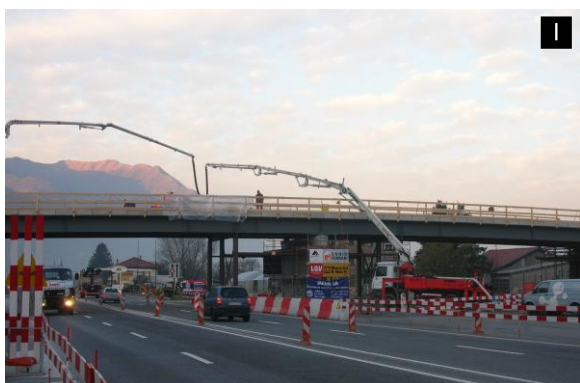
Ponte provvisorio su Strada Cantonale Lotto 751 - AlpTransit Nodo di Camorino
