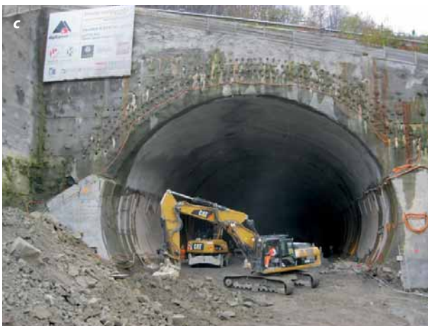
9 Ausbruch Paramentstollen mit Jettingarbeiten im linken Stollen (Bild a), Kalottenausbruch in der 1. Etappe (Bild b) und Strossen- und Sohlausbruch (Bild c) Excavation of wall heading with jetting operations in the left tunnel (Fig. a), crown excavation in the 1 st stage (Fig. b) and bench/invert excavation (Fig. c)
