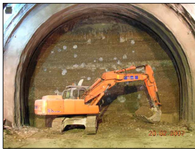
Lotto 8A: Sezione C2 - Fronte di Scavo lato Milano
