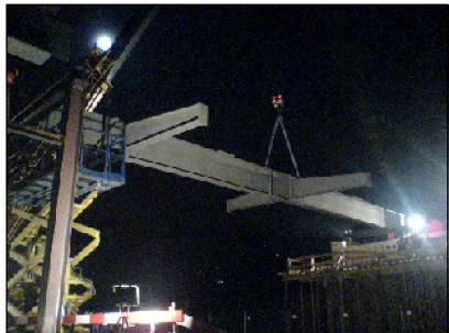
AlpTransit - Nodo di Camorino Lotto 715 - Ponte provvisorio su SC
