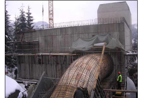
Ampliamento centrale di ventilazione Airolo (DLL) 2003-2004
